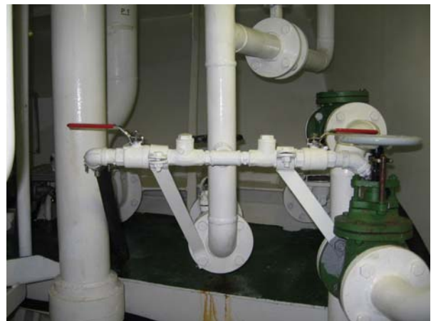
Pickages de sortie de l'analyseur CO 2 (à gauche) et du thermosalinographe (à droite).
