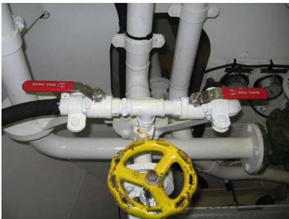
Pickages d'entrée de l'analyseur CO 2 (à gauche) et du thermosalinographe (à droite).
