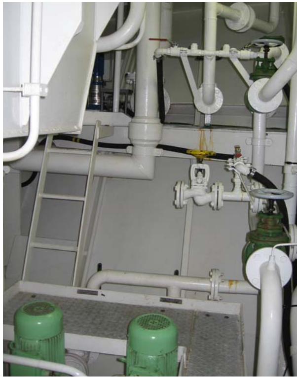
Vue des pickages d'entrée et de sortie de l'ensemble CO 2 + thermosalinographe.
